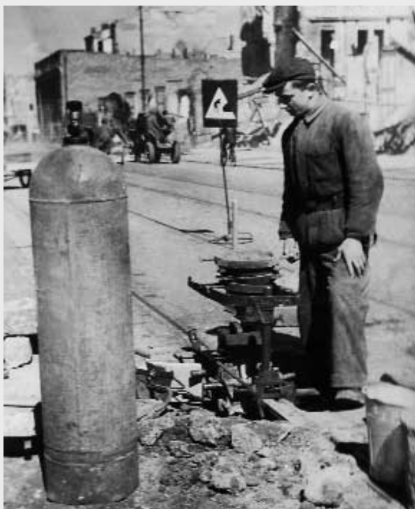
Warszawa, 1945, układanie szyn tramwajowych na ul. Marszałkowskiej.
